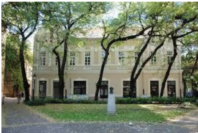
Обновљена фасада зграде Школе 2014. године
