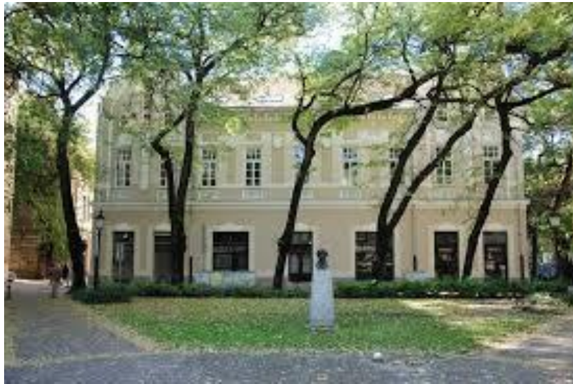
Обновљена фасада зграде Школе 2014. године
